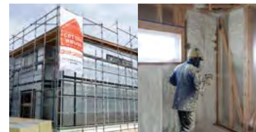
ダブル断熱工法
